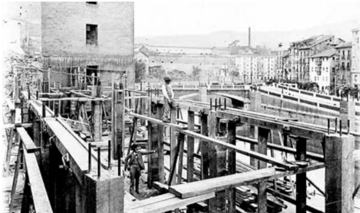
LA CERES marcó un hito arquitectónico: fue el primer edificio de hormigón armado. / BIBLIOTECA FORAL
