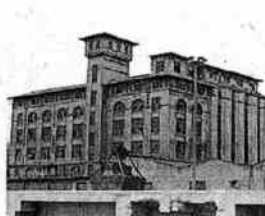
12 Molinos Vascos. BILBAO. Se construyó para alojar una fábrica harinera.
