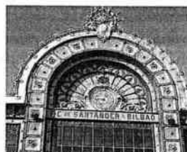
8 Estación de Santander. BILBAO. Reconocible por su peculiar fachada.
