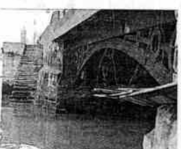
30 Puente Urdondo. LEIOA. Más antiguo puente de fundición. Hubo que demolerlo en 1878.
