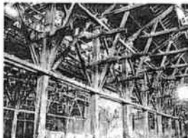
16 Pabellón Ercross. BARAKALDO. Ejemplo de arquitectura industrial de madera.
