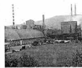
19 Sefanitro. BARAKALDO. Albergó una fábrica de abonos químicos. Ha sido derribado.
