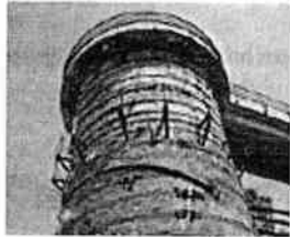
5 Horno de calcinación. ABANTO. Es de los más comunes que se emplearon en la zona minera.
